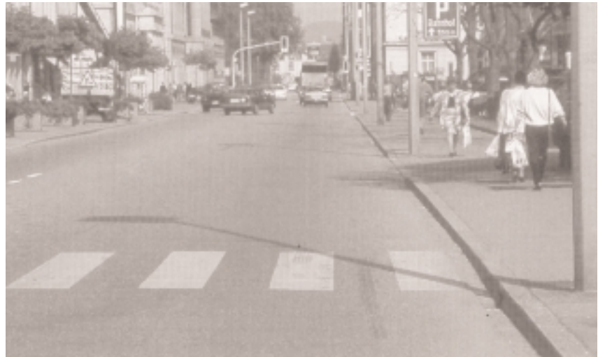
Bahnhofstraße in Aarau, nach 18jähriger Betriebsdauer ist der Trinidad-Belag rissfrei und ohne Deformationen
