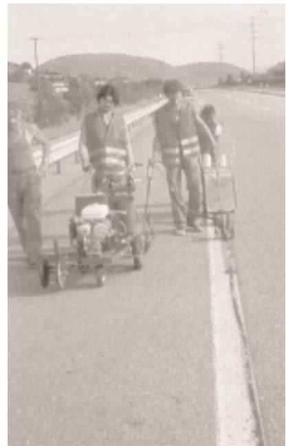
Nationalstraße N1, Unterhaltungsarbeiten der Asphaltdeckschicht im Abschnitt Baden-Spreitenbach
