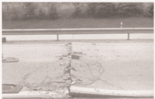
Nationalstraße N1 Rothrist-Baden, Schäden der Betondecke
