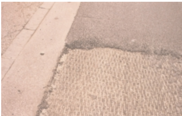
Anfräsen der vorhandenen Decke entlang der GA-Rinne cm dicken Zementbetontragschicht waren 3,5 cm Asphaltbinder 0/16 und eine 3,5 cm Gussasphaltdeckschicht einge-
