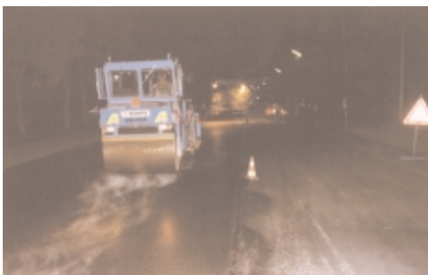
Nachteinbau im Zuge der Aschenbrenner Straße – SMA 0/5 Plus mit Trinidad NAF 501
