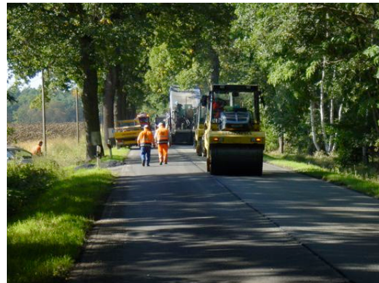
Einbau auf der B 87
