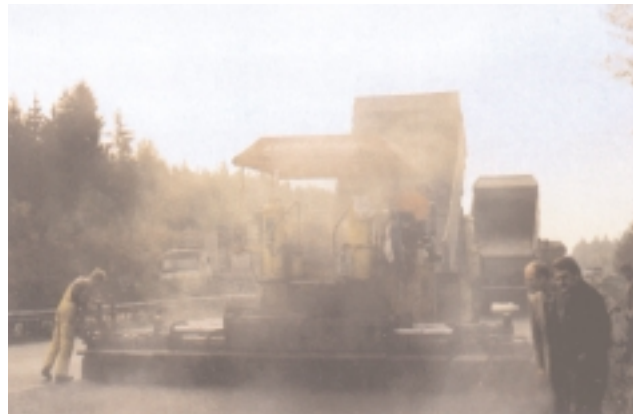
Bild 2: Einbau SMA 0/11 mit NAF 501 Siloware
